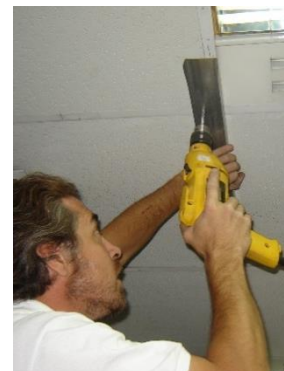
INSTALAR PERFIL SUPERIOR
