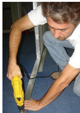
INSTALAR PERFIL INFERIOR
