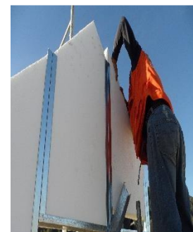
INSERTAR BOVEDILLAS A TRAVES DE PERFILES
