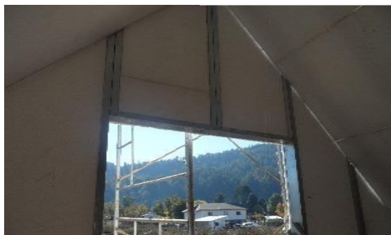
MONTAR TECHO EXACTA PARA ESTRUCTURAR MUROS PERIMETRALES
