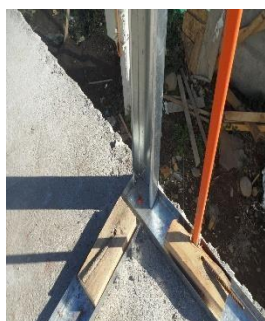
INSTALAR PERFIL INFERIOR (SOLERA)
