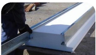
ARMAR BOVEDILLAS
