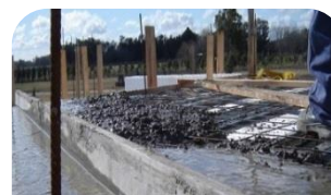
VACIAR EL HORMIGÓN
