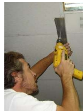
INSTALAR PERFIL SUPERIOR
