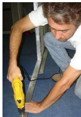
INSTALAR PERFIL INFERIOR
