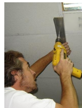
INSTALAR PERFIL SUPERIOR
