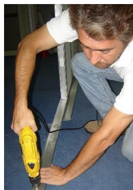
INSTALAR PERFIL INFERIOR
