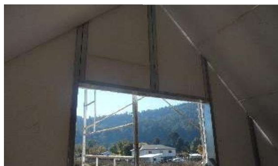
MONTAR TECHO EXACTA PARA ESTRUCTURAR MUROS PERIMETRALES
