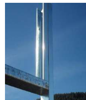
MEDIR ALTURA PISO A CIELO E INSTALAR PERFIL
