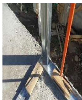
INSTALAR PERFIL INFERIOR (SOLERA)
