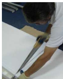
RECORTAR BOVEDILLAS DE ACUERDO A MEDIDAS
