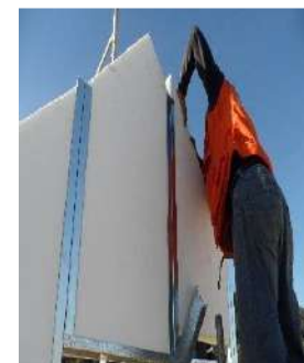
INSERTAR BOVEDILLAS A TRAVES DE PERFILES
