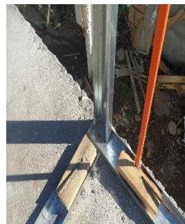
INSTALAR PERFIL INFERIOR (SOLERA)
