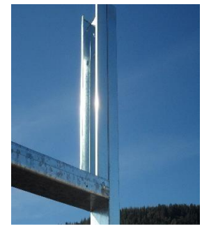
MEDIR ALTURA PISO A CIELO E INSTALAR PERFIL
