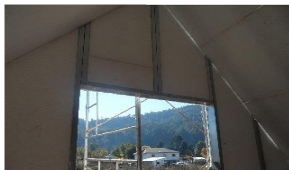
MONTAR TECHO EXACTA PARA ESTRUCTURAR MUROS PERIMETRALES
