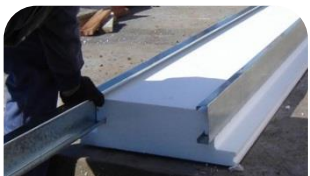
ARMAR BOVEDILLAS
