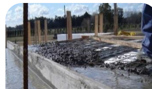
VACIAR EL HORMIGÓN
