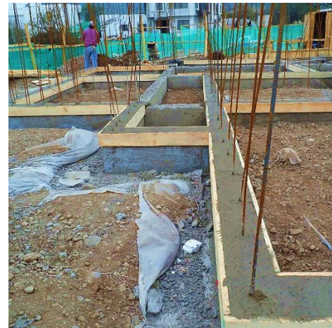
Anclaje de tensor a fundación
