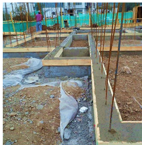
Anclaje de tensor a fundación
