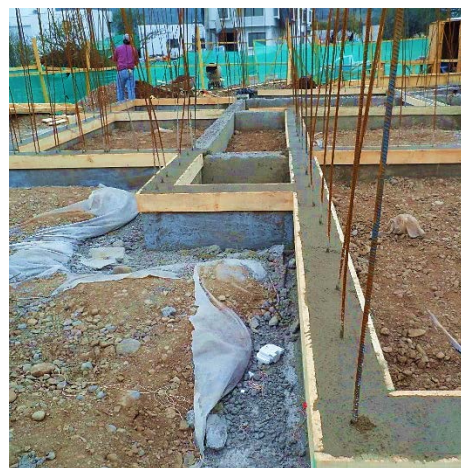
Anclaje de tensor a fundación
