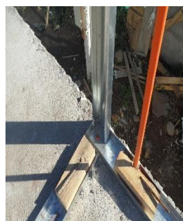
INSTALAR PERFIL INFERIOR (SOLERA)
