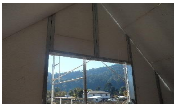
MONTAR TECHO EXACTA PARA ESTRUCTURAR MUROS PERIMETRALES
