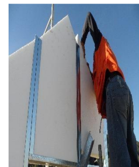
INSERTAR BOVEDILLAS A TRAVES DE PERFILES
