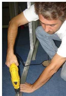
INSTALAR PERFIL INFERIOR
