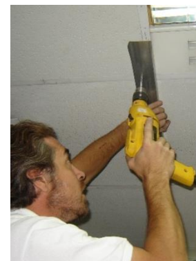
INSTALAR PERFIL SUPERIOR
