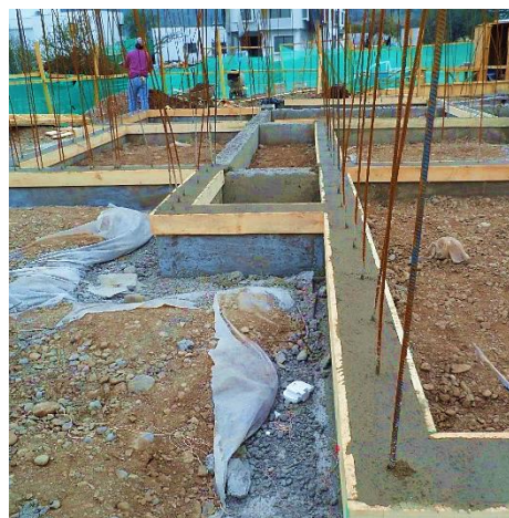
Anclaje de tensor a fundación
