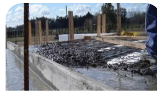
VACIAR EL HORMIGÓN
