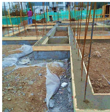
Anclaje de tensor a fundación
